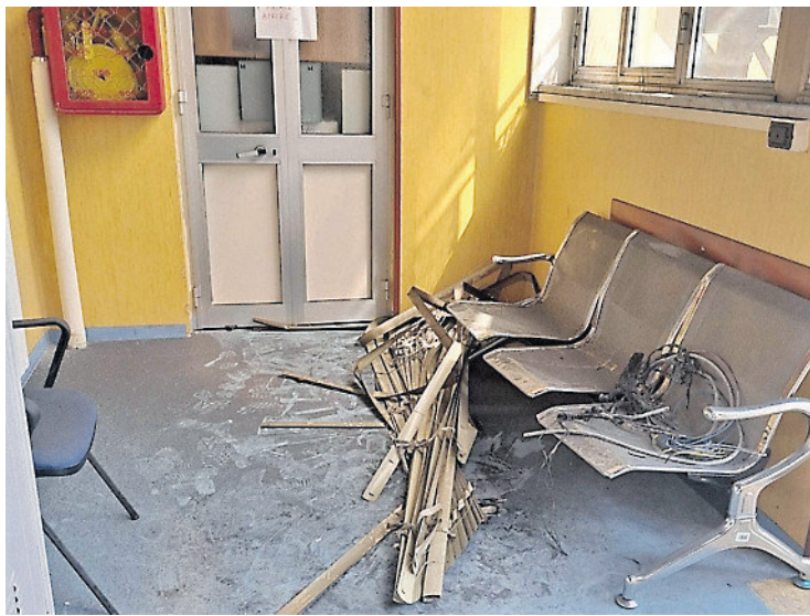
L'INCIDENTE I danni provocati dall'incendio a un condizionatore nel distretto sanitario 37 dell'Asl 2 Nord a Giugliano
